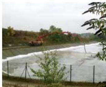
Mise en place étanchéité et bétonnage fond bassins
