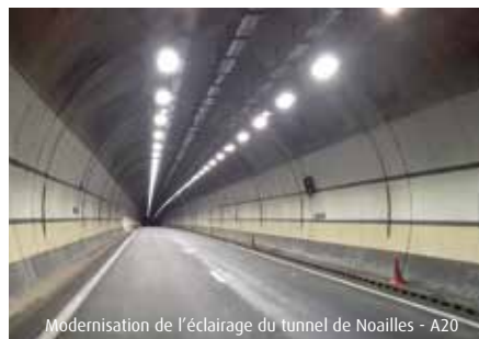
Modernisation de l'éclairage du tunnel de Noailles - A20
