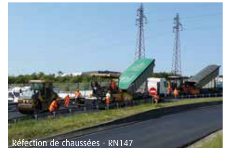
Réfection de chaussées - RN147
