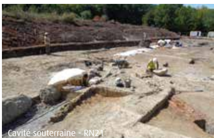
Cavité souterraine - RN21
