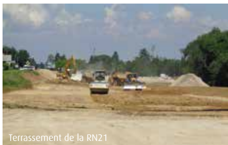
Terrassement de la RN21
